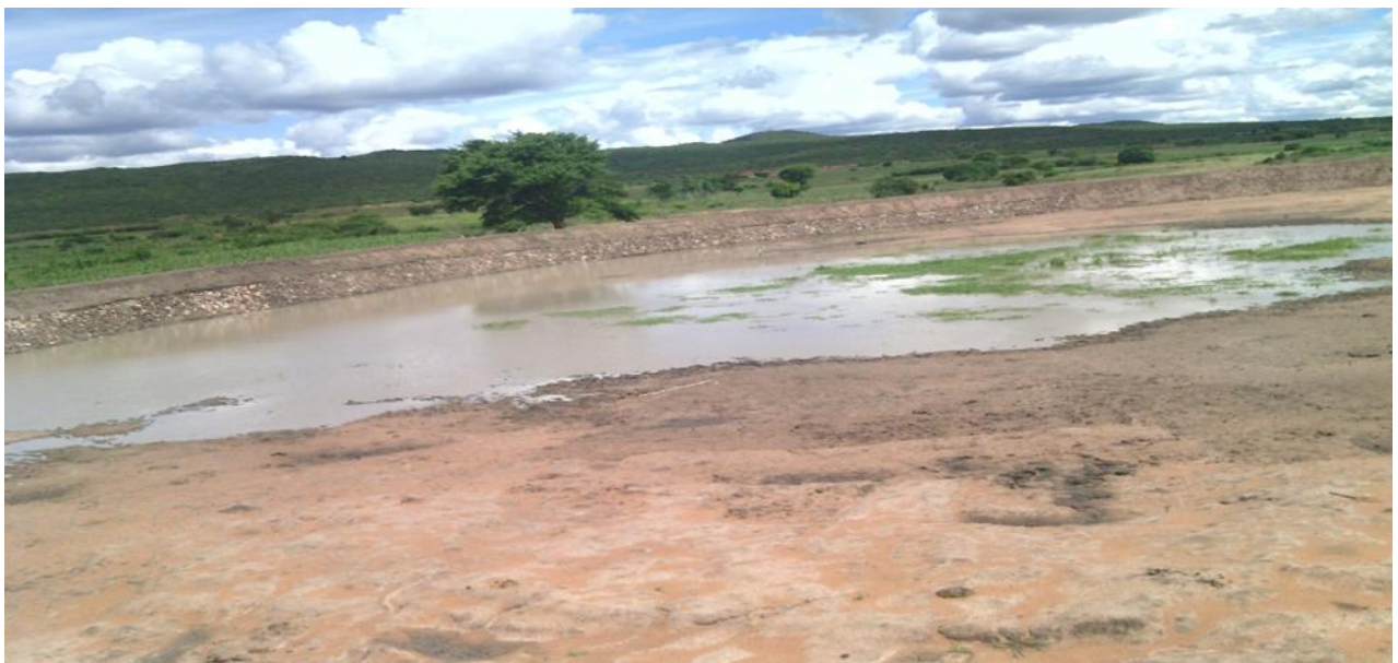
Ujenzi wa lambo Kijiji cha Inonelwa
